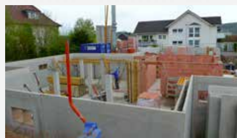
Die Arbeiten am Sugambernweg gehen planmäßig voran
