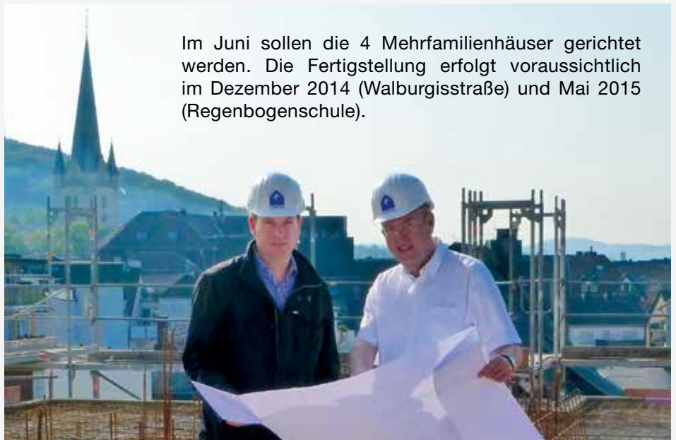
Baustellenterrin: Vorstandsvorsitzender Manfred Döring (rechts), GEWOG-Architekt Frank Barnbeck (links)
