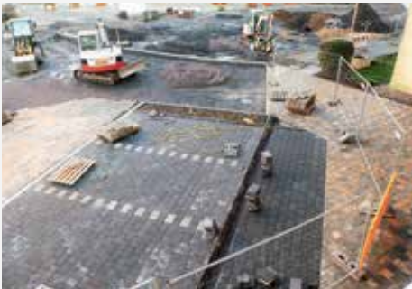
Neue Wegeführungen und Kfz.-Einstellplätze sind bereits erkennbar am Lendringser Platz
