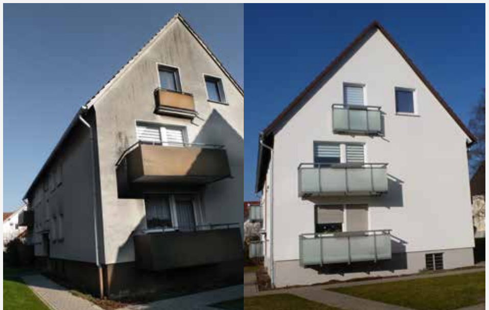
Gelungenes Beispiel einer Modernisierung in 2016 der Außenfassaden und Balkone der GEWOG-Häuser in der Wielandstraße in Böserpe
