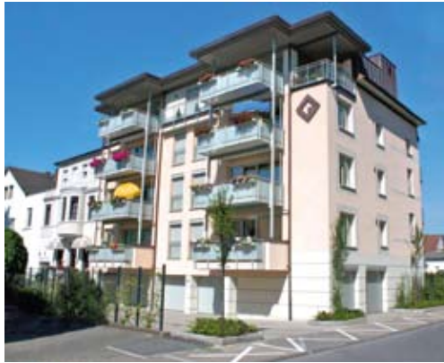
Neubau Gartenstr. 9, Menden-Innenstadt
