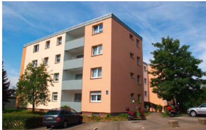
Hunsrückstr. 14 nach umfassender Modernisierung
