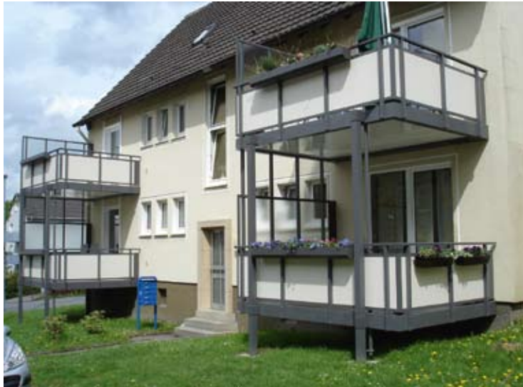
Balkonanbauten Oberm Rohlande
